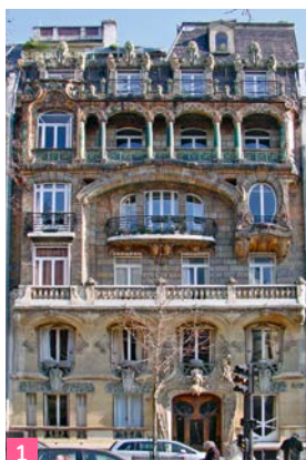
1 Immeuble, avenue Rapp, Jules Lavirotte, architecte.
