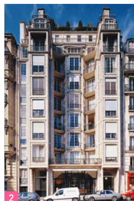
2 Immeuble, rue Franklin, Auguste et Gustave Perret, architectes.
