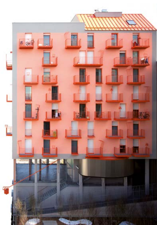
Immeuble de logements étudiants de l'architecte Stéphane Maupin dans le quartier universitaire de Paris Diderot.
