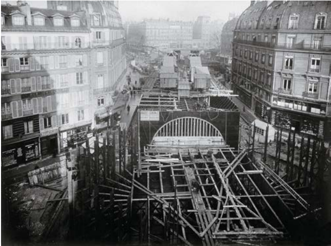
Les travaux de construction du métropolitain à la station Saint-Michel en 1907.
