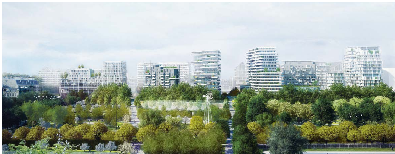
Le nouvel éco-quartier de Clichy-Batignolles, situé aux abords de la porte de Clichy est construit sur d'anciens terrains ferroviaires. Actuellement en cours d'aménagement, il comportera 3 400 logements, des équipements, des commerces autour d'un grand parc de 10 hectares.
