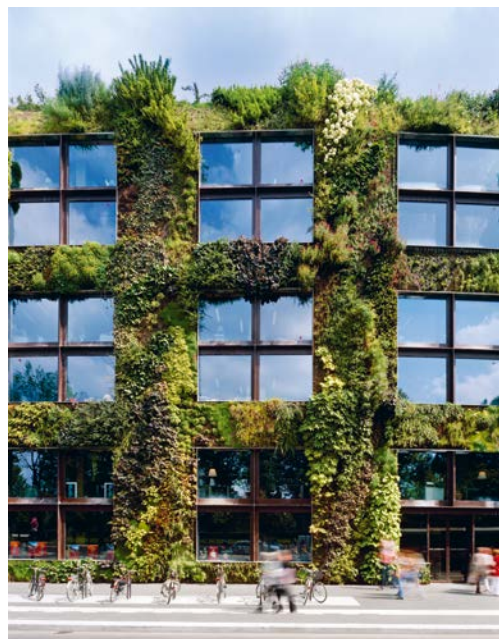
La façade végétalisée du musée du Quai Branly a été conçue par Jean Nouvel avec Patrick Blanc. La couverture végétale de l'extérieur des bâtiments permet d'améliorer l'isolation thermique et phonique et participe au maintien de la biodiversité en abritant de nombreux animaux.
