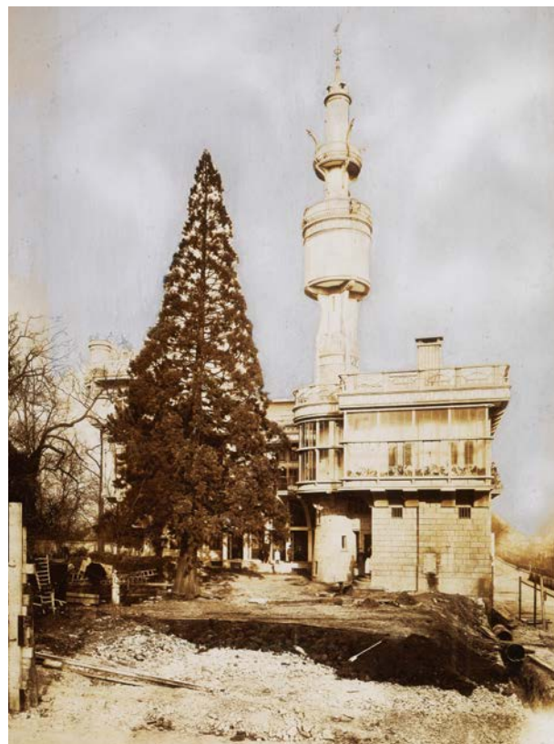
La villa Hennebique à Bourg-la-Reine, une démonstration, en 1903, de l'ingénieur sur les possibilités qu'offre le béton armé, un matériau mis au point à la fin du XIX e siècle.
