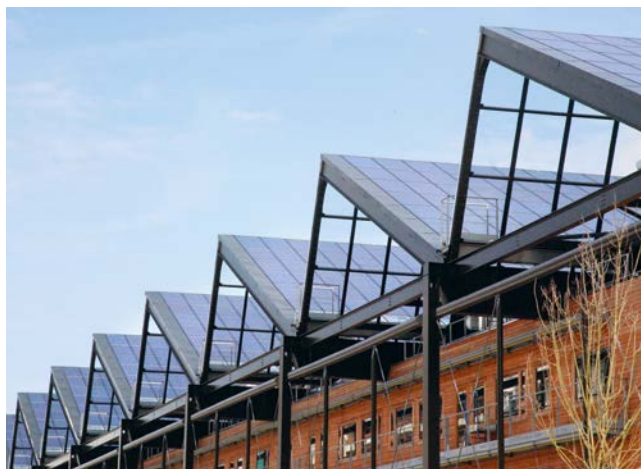
La réhabilitation de cette ancienne halle SNCF désaffectée, située dans le 18 e arrondissement a été conçue par Françoise-Hélène Jourda dans une logique de développement durable. Grâce à ses 3500 m 2 de panneaux photovoltaïques, la halle Pajol est la première centrale solaire urbaine de France. Elle accueille des équipements, des commerces, des entreprises et un jardin couvert. La halle et les bâtiments voisins ont reçu le label d'éco-quartier.
