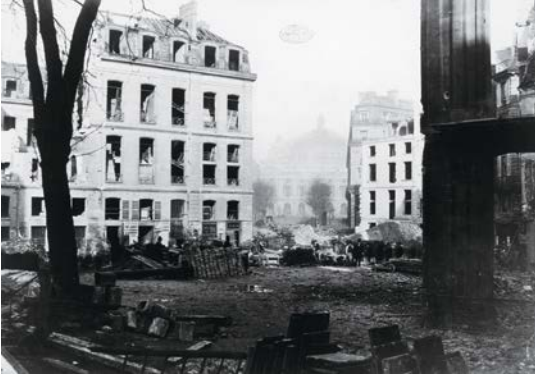
Démolition des habitations du quartier de l'Opéra afin de réaliser une avenue.
