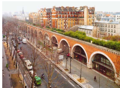
Promenade plantée réalisée en 1994 sur un ancien viaduc réhabilité par Patrick Berger, dans le 12 e arrondissement.
