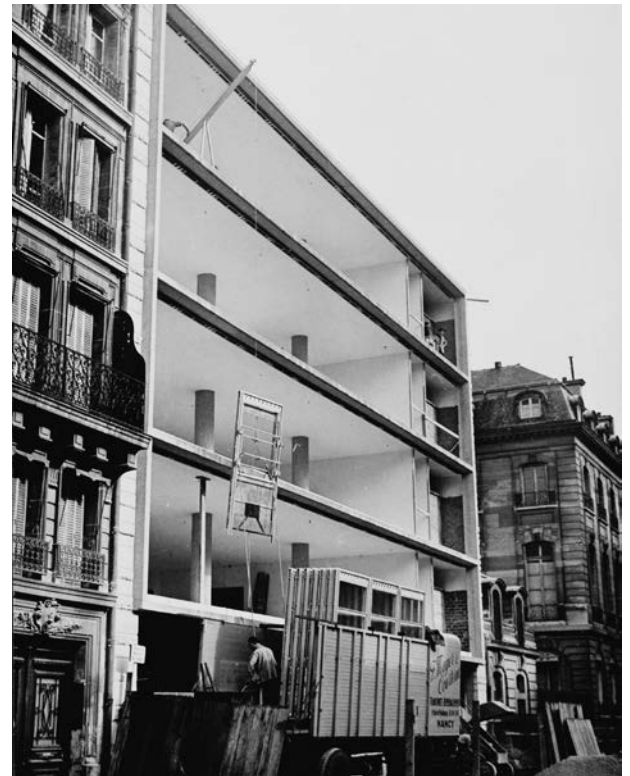
Montage de la façade de la Fédération française du bâtiment conçue par Jean Prouvé, 1948.
