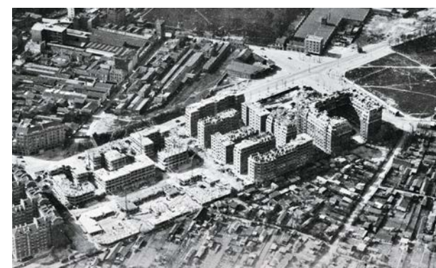
Des immeubles de logement à bon marché en construction sur l'emplacement de l'ancienne enceinte. Au premier plan, les bidonvilles de la « zone ».
