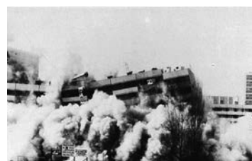
Destruction d'une barre d'immeubles de la cité des 4 000 à La Courneuve (Seine-Saint-Denis), en 1986.
