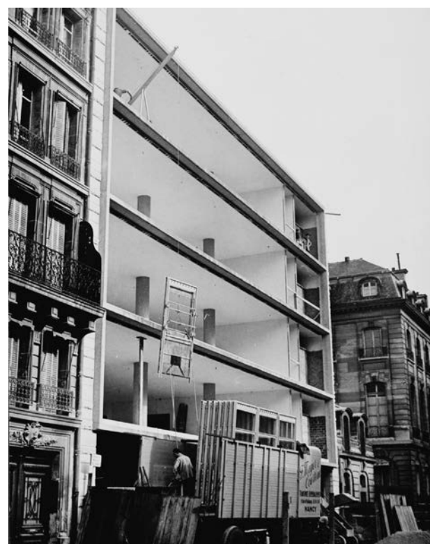
Montage de la façade de la Fédération française du bâtiment conçue par Jean Prouvé, 1948.
