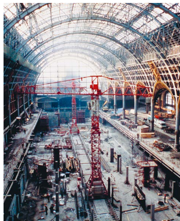
Chantier de transformation de l'ancienne gare d'Orsay en musée, vers 1985.
