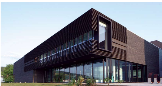
Musée Fjord - 2001 Musée du Fjord de La Baie, Saguenay Dupuis Letourneux, architectes photo : Dupuis Letourneux, architectes
